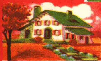
Hostería terminada, 30 personas
